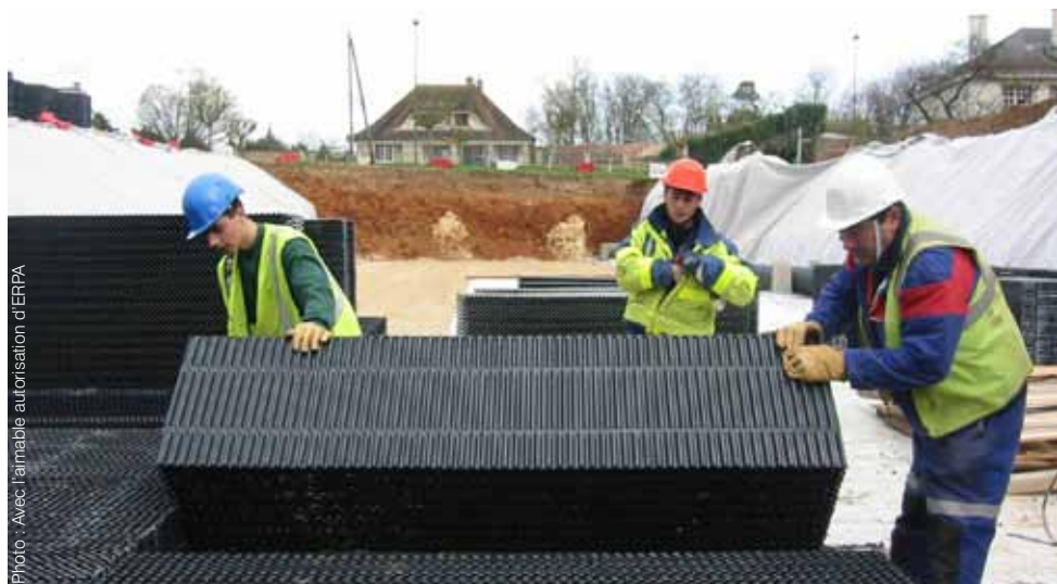
Modules aquifères ultra légers en film de PVC rigide recyclé
